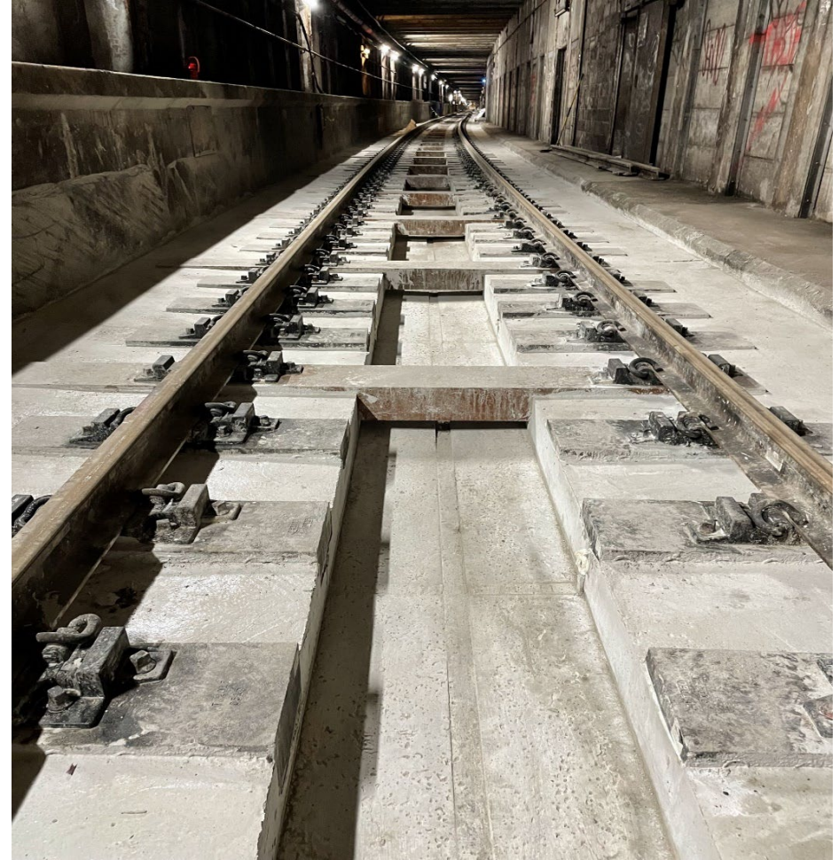
Rebuilt concrete track on Archer Av Line
