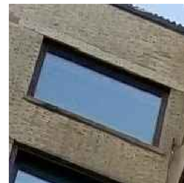
EXISTING WINDOW E3
