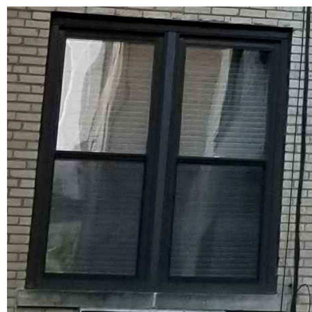
EXISTING WINDOW E2
