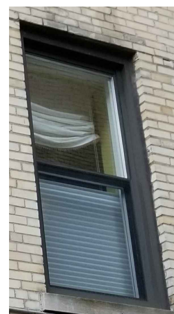
EXISTING WINDOW E1
