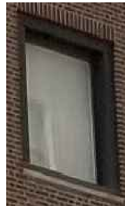
EXISTING WINDOW E3
