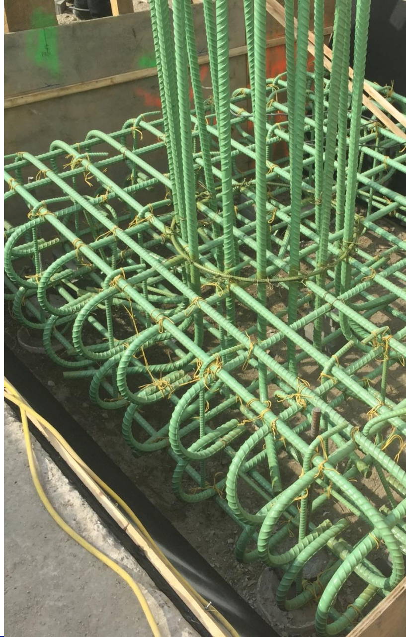
Install Rebar Cages and Pour Concrete for Pile Caps
